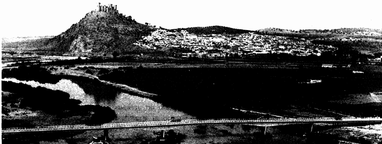
Puente de Almodóvar del Río, 1962.
