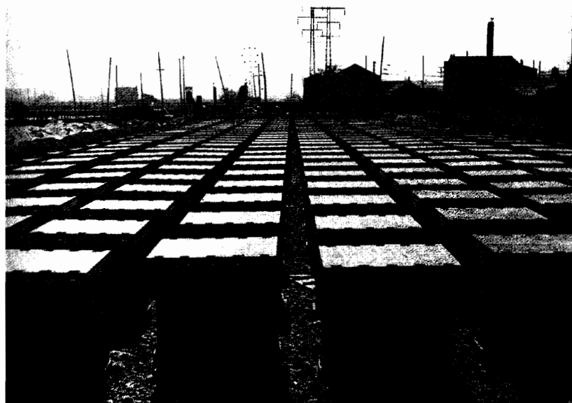
Parque de dovelas de la cubierta de la calle Aragón. Barcelona, 1959.
