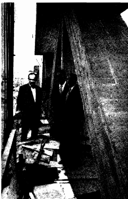
En una de las vigas trianguladas de Avilés, 1957.
