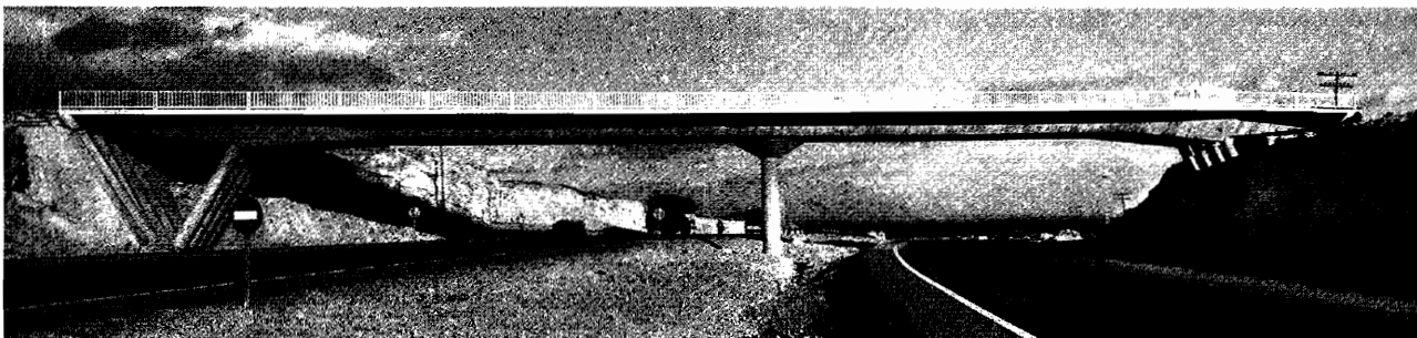
Paso superior de Hoyo de Manzanares sobre la autopista Las Rozas-Villalba.
