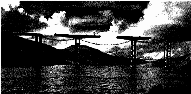
El viaducto de Iznajar, durante el proceso constructivo.
