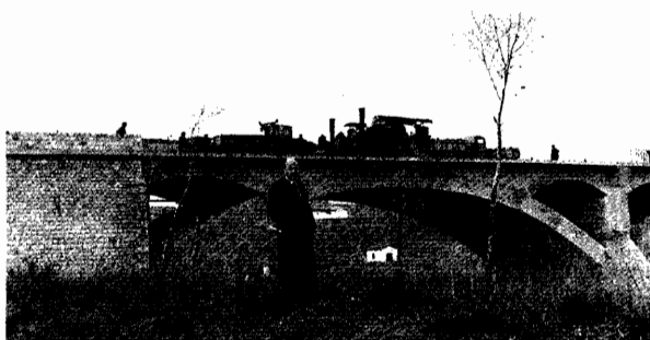
Puente sobre el río Besós en construcción.
