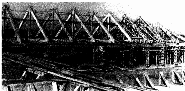
Cerchas prefabricadas de la Escuela de Ingenieros de Montes. Madrid, 1942.
