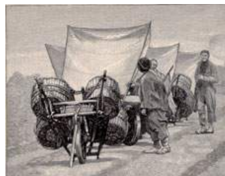
Carretilla china dotada de rueda de gran diámetro, para transitar por todo tipo de caminos. La carga se encuentra dispuesta simétricamente a cada lado de la rueda y coincidente con el eje, a fin de permitir la necesaria maniobrabilidad.
