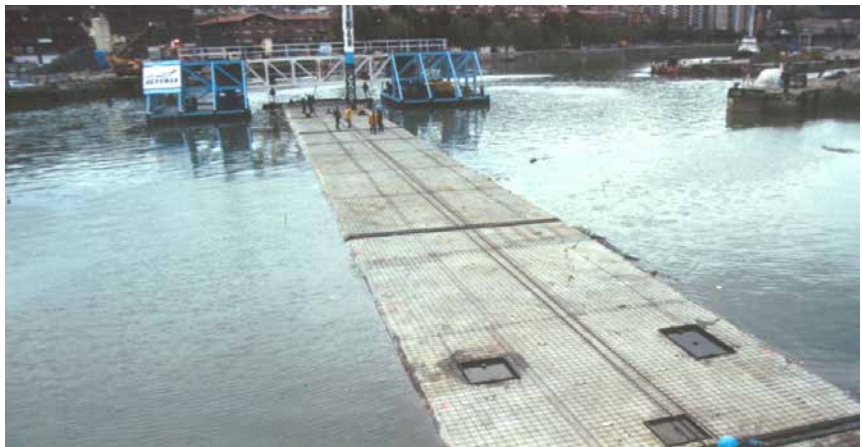
Paso subfluvial Deusto - Olabeaga
